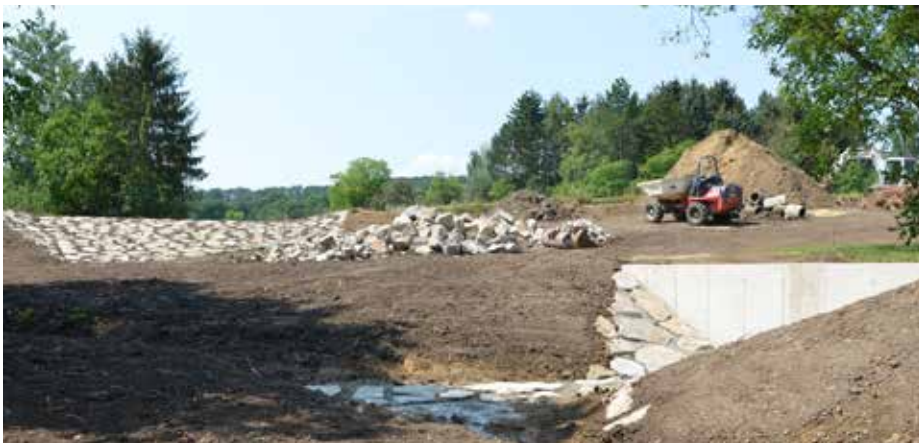
Die Bauarbeiten beim Hochwasserschutzprojekt in Pyhra gehen gut voran.
